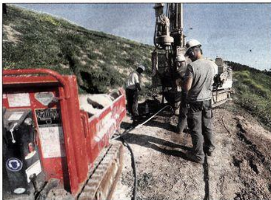
La réalisation du site 3 a été confiée à l'entreprise RBTP-Eurovia.
