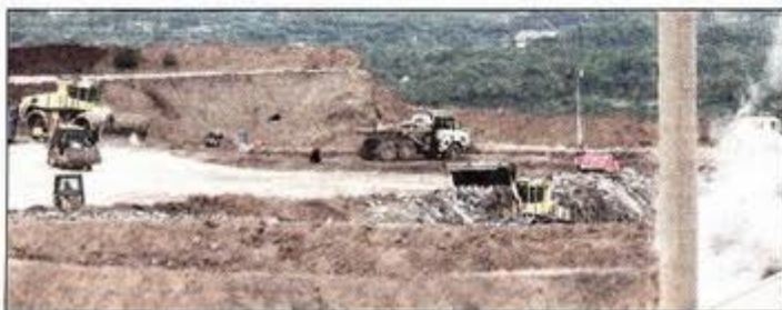
Au Balançon, 15 millions de tonnes sont déjà enfouies.
