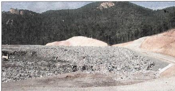
Sur cette photo, « la décharge » en 2004, fermée depuis octobre 2011.
