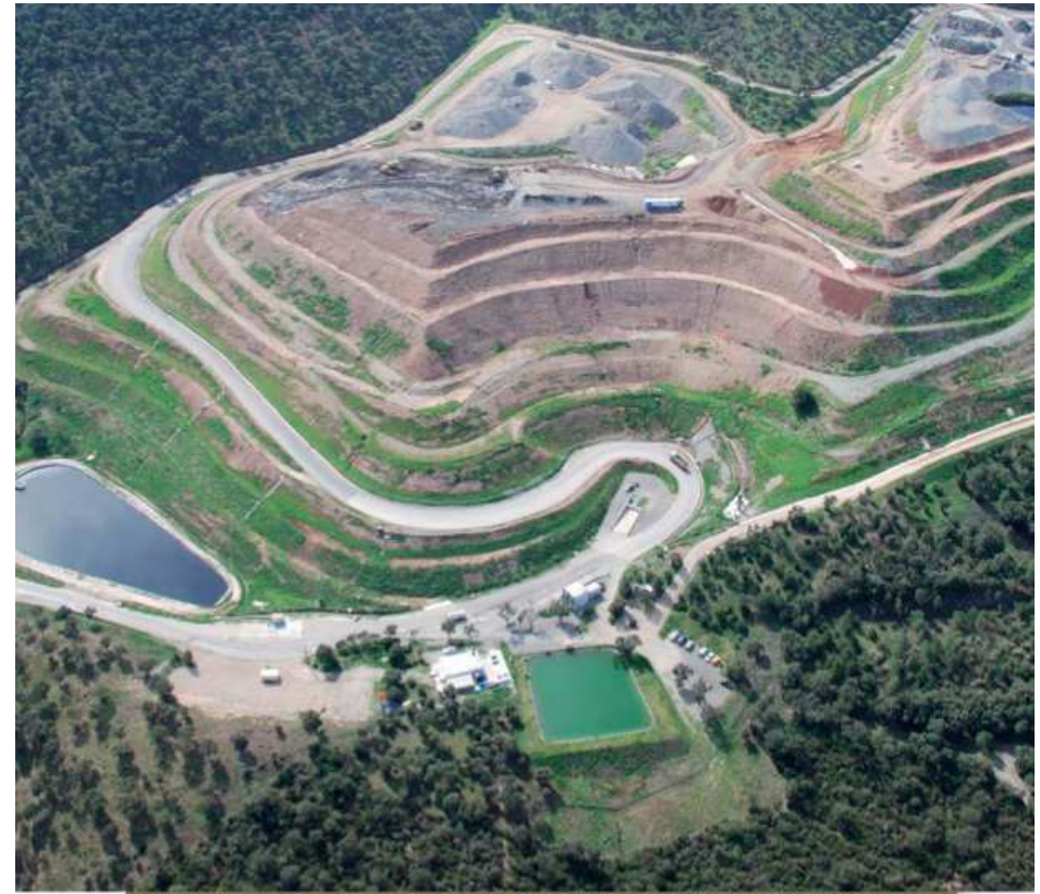
Centre de stockage de déchets non dangereux de Pierrefeu
